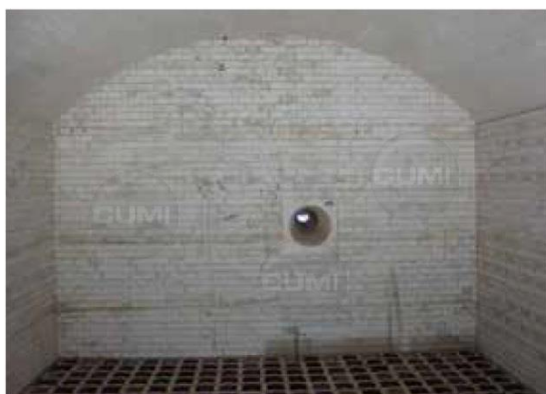
Кирпичи из плавленного муллита для боковой стены, настильной стены и свода - CUMILITE WHF
